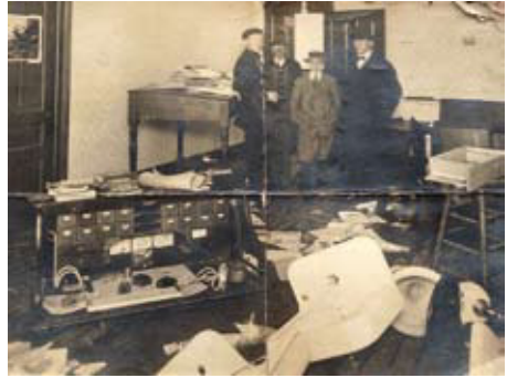
Abb. 4: Der Einbruch 1911 in die Geschäftsräume Quelle: Linda Eddings, Florida
